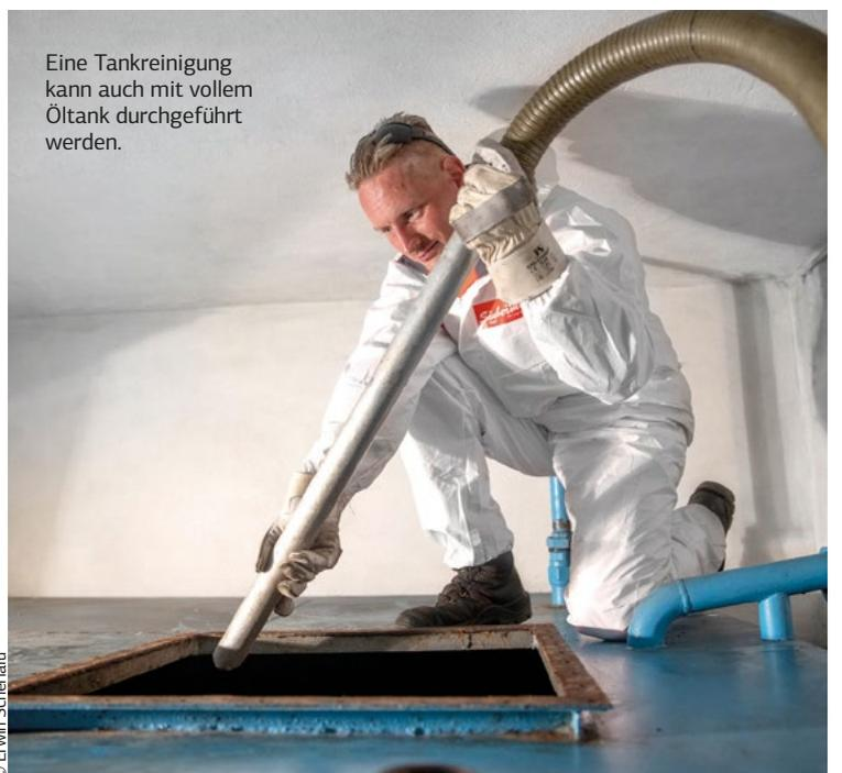
Eine Tankreinigung kann auch mit vollem Öltank durchgeführt werden.
