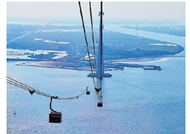
Mit 214 Metern die welt höchste Seilbahn, gebaut von Doppelmayr
