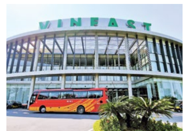
In nur 18 Monaten wurde die neue Autofabrik von Vinfast errichtet.
